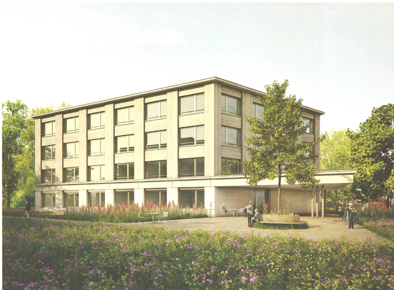
Visualisierung Neubau Alterswohnungen Obere Mühle zvg
