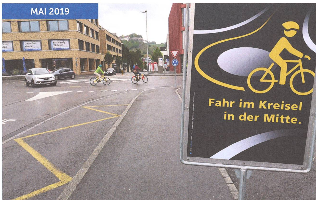
In der Mitte besser sichtbar: Velofahrer auf dem Bahnhofkreisel FT
