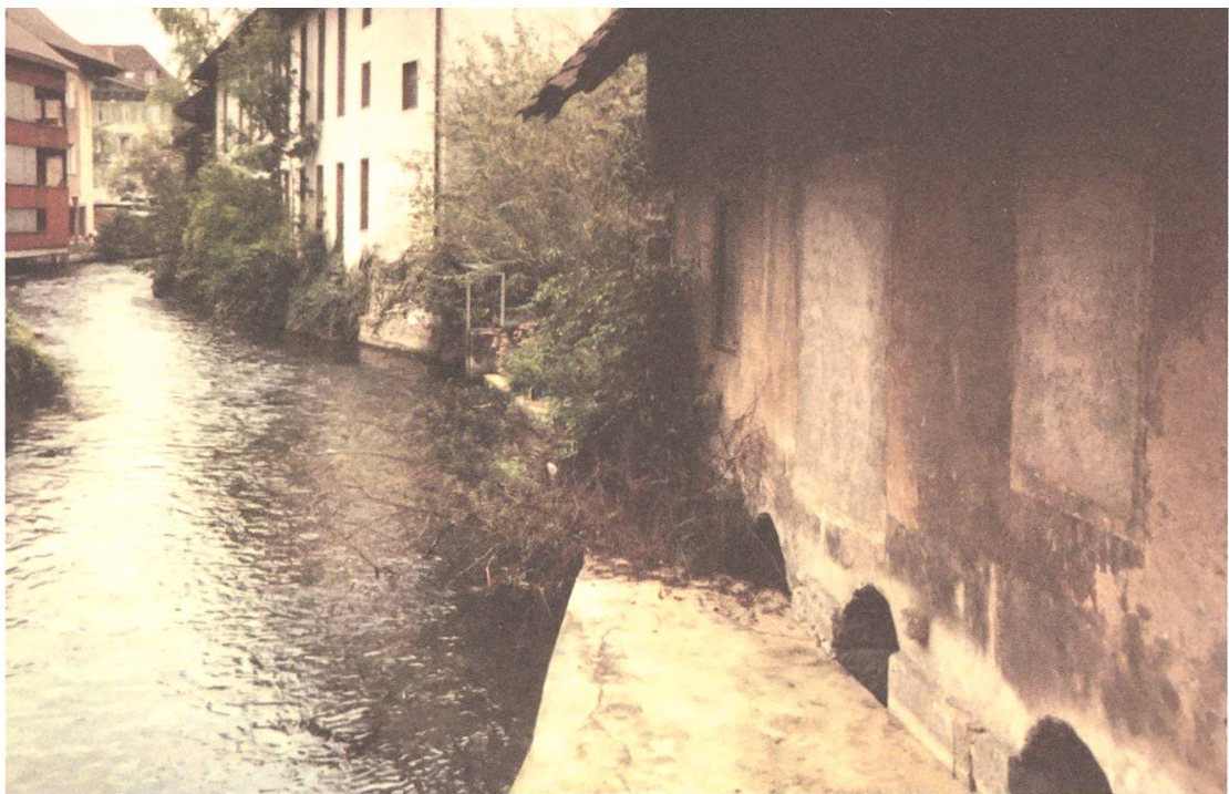
Chlorbadhaus in der unteren Bleiche, abgebrochen 1997 KB
