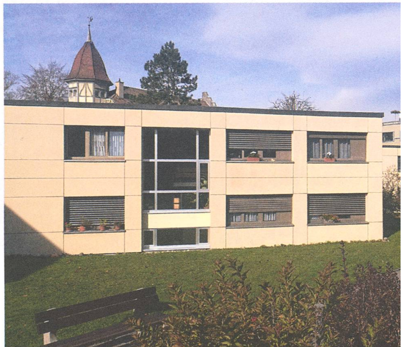
Obere Mühle: hier entstehen neue Alterswohnungen FT
