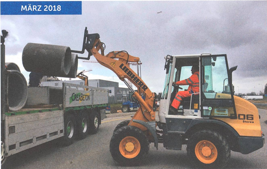
Erste Bau-Vorbereitungen beim Knoten Neuhof JG
