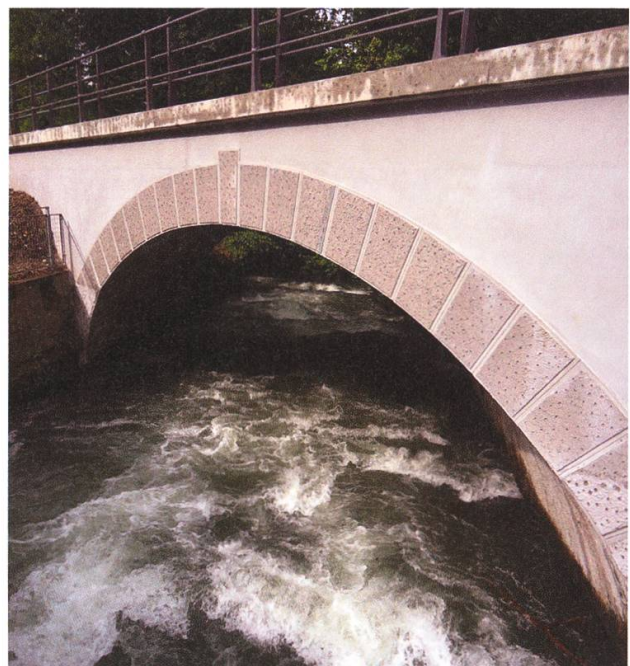
Die älteste Betonbrücke der Schweiz. Foto PW
