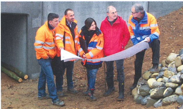
Neue Unterführung für Vierbeiner. Foto AG
