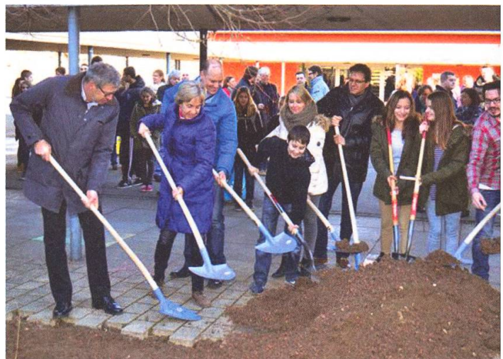
Spatenstich für den neusten Neubau 2016.
