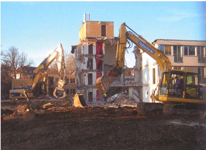
Der Altbau wurde Ende 2013 abgebrochen.
