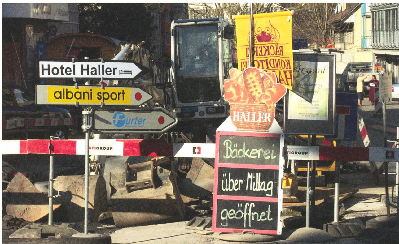
Das Lenzburger Gewerbe fühlte sich von den Baustellen der Kerntangente beengt, die Not machte jedoch erfinderisch. Foto HH.
