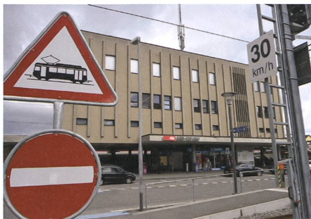
Das Aufnahmegebäude am Bahnhofplatz wird aus Platzgründen weichen müssen. Foto FT
