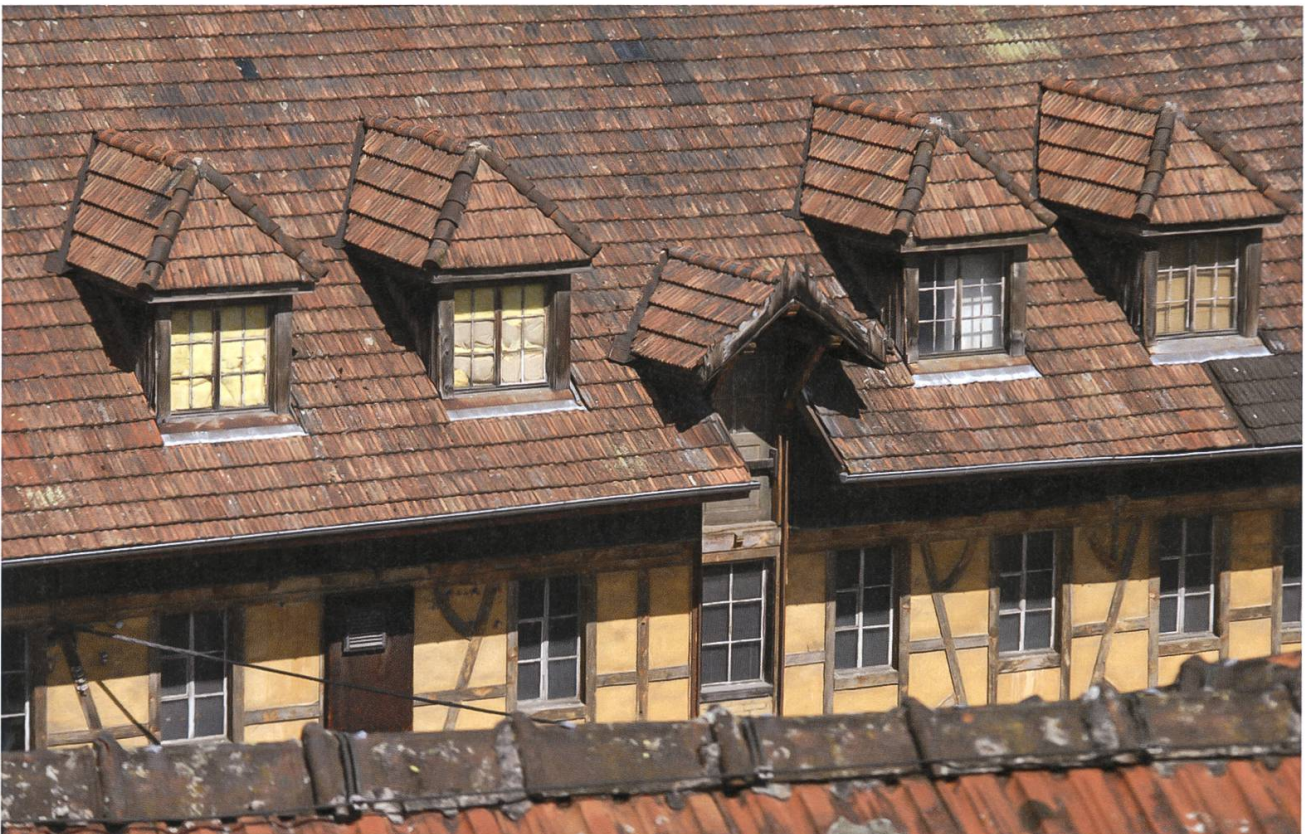
Fassaden- und Dachausschnitt Haus B.
