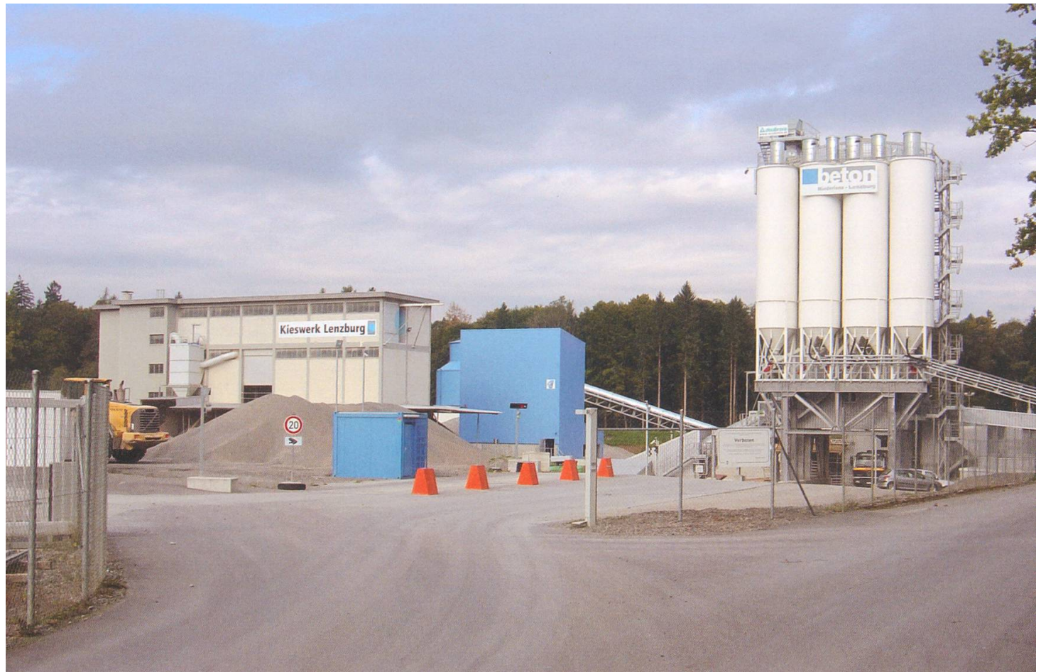
Das Kieswerk Lenzhard ist für die Ortsbürgergemeinde ein finanziell wichtiges Standbein. Foto ZVG
