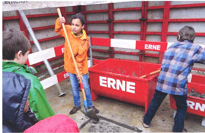
Kinder betonierten gute Wünsche ein. Foto TF
