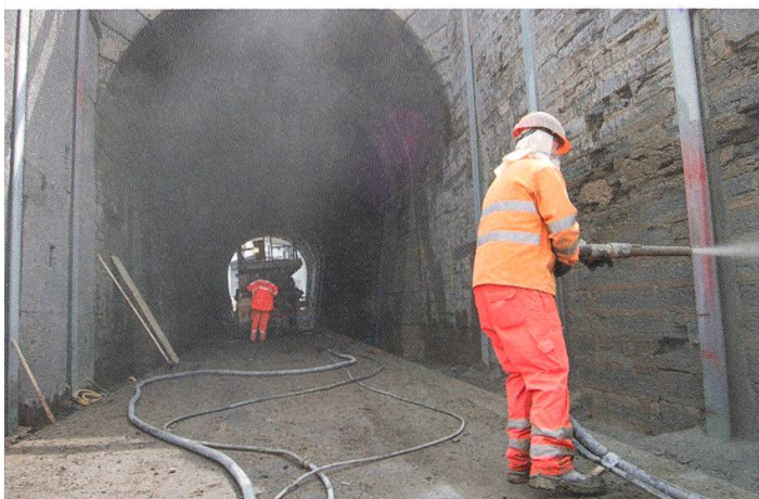
Der Seetalbahntunnel wird saniert. Foto HH.
