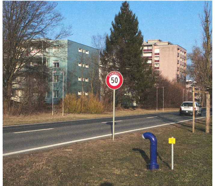
Das Fünflindenquartier bekommt eine 393 m lange Lärmschutzwand. Foto AG
