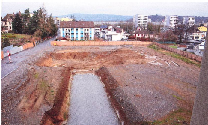
Auf der stillgelegten Baustelle des Mühlematt-Schulhauses geht es bald weiter. Foto TW
