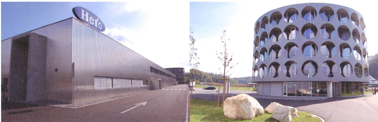
Die Architektur der Hero-Bauten Fabrik und Firmensitz im Hornerfeld symbolisiert, was drinnen passiert. Foto: HH.
