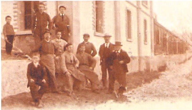
1906 vor Neubau mit Arbeitern.
