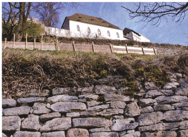
Neue Trockenmauern sichern den Schlosshang.
