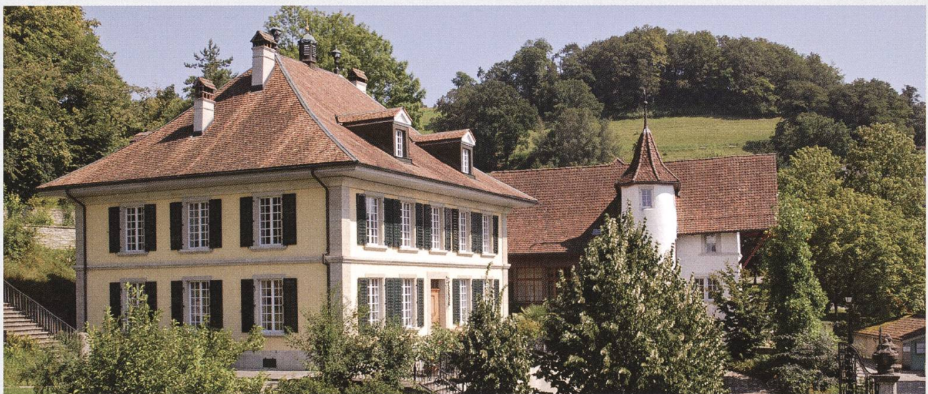
Die Burghalden-Baugruppe der Ortsbürger-Gemeinde dient öffentlichen Zwecken. Foto: Hans Weber
