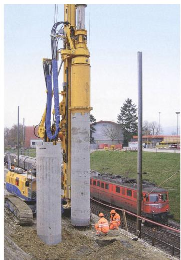
Erstellen der Bohrpfähle für die Pfahlwand Foto: D. Salzmann
