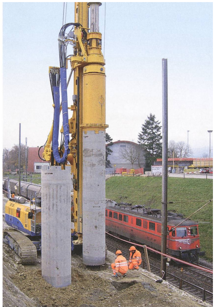
Erstellen der Bohrpfähle für die Pfahlwand
