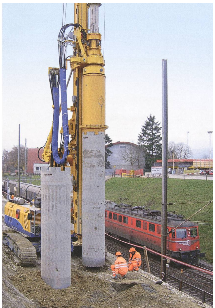
Erstellen der Bohrpfähle für die Pfahlwand
