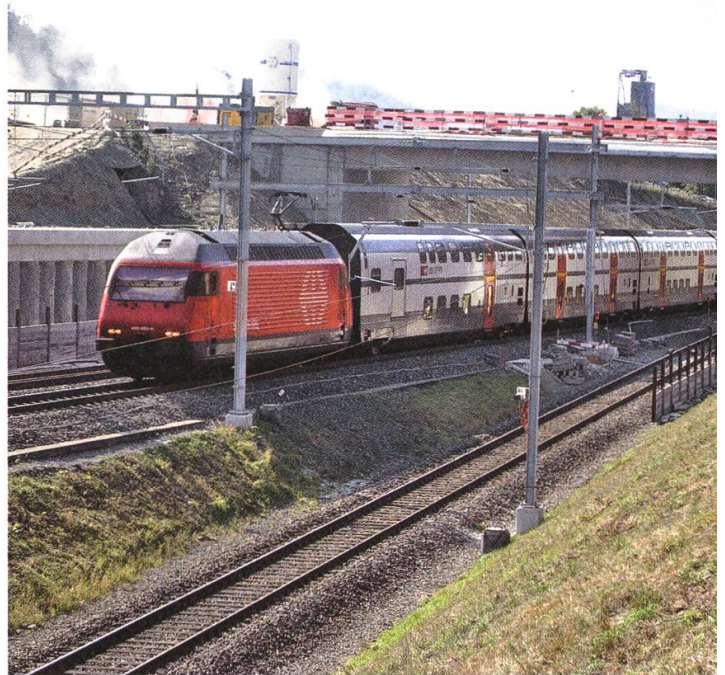
Neue Gexibrücke, im Vordergrund das Gleis zur Unterwerfung Richtung Freiamt Foto: D. Salzmann
