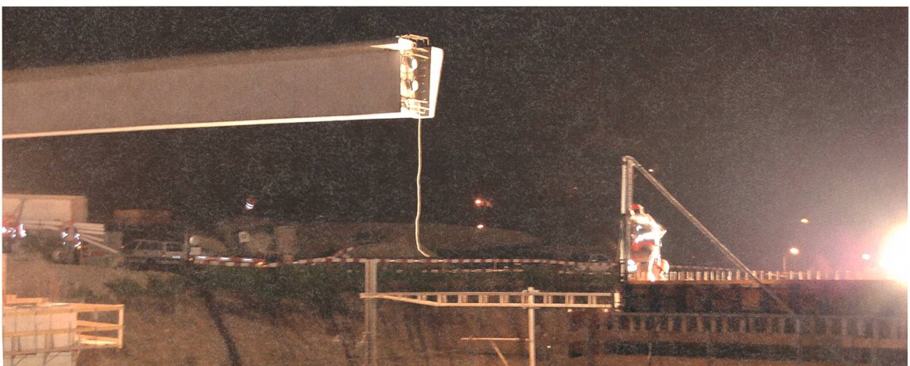
Die Arbeiten an der Gleisgrossbaustelle (Bild Gexi-Brücke) werden Tag und Nacht vorangetrieben.
