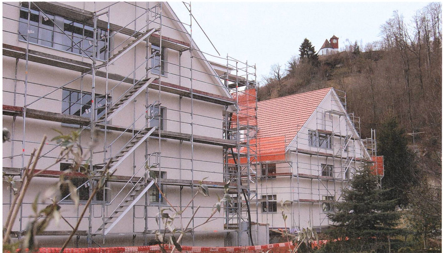
Die neueren Quartiere wirken dank reger Bautätigkeit städtisch. Foto: HH.
