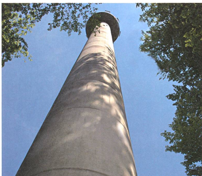
Lenzburger Ortsbürgern gehört der Esterliturm. Foto: TO.
