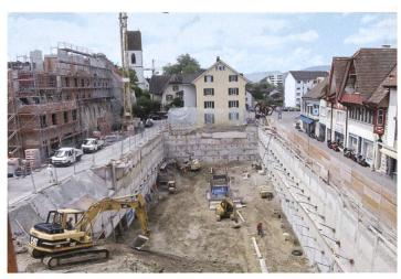
Baugrube der Tiefgarage für die Stadtmauer-Überbauung. Foto: HH.
