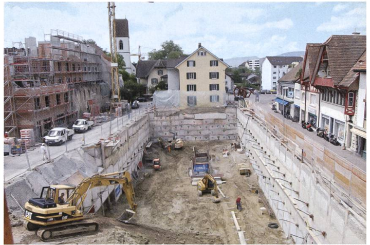
Baugrube der Tiefgarage für die Stadtmauer-Überbauung. Foto: HH.
