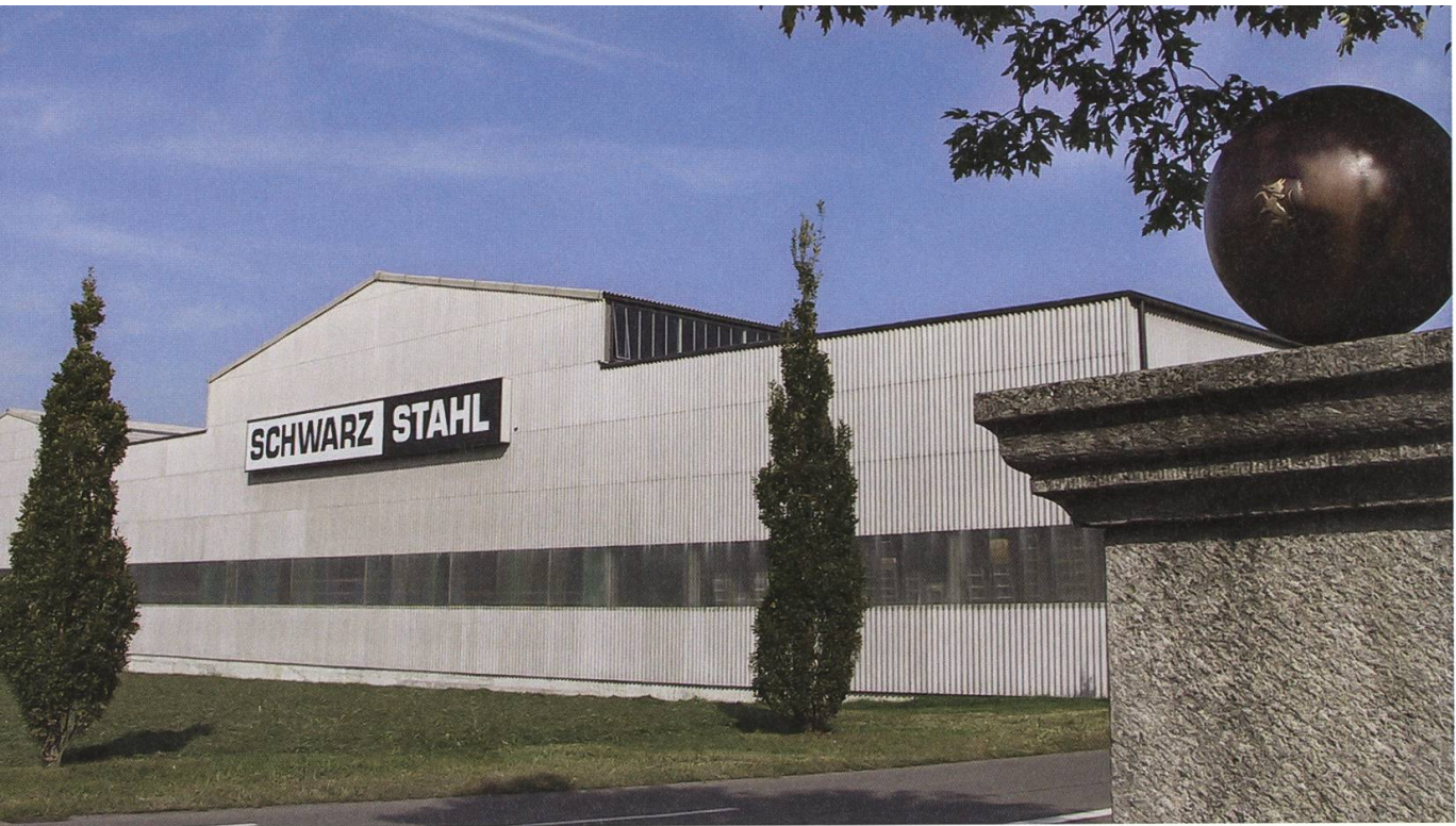
Laden, Lager, Betriebs- und Büroräume sind im Lenzhard beim Bahnhof konzentriert. Foto: Schwarz.
