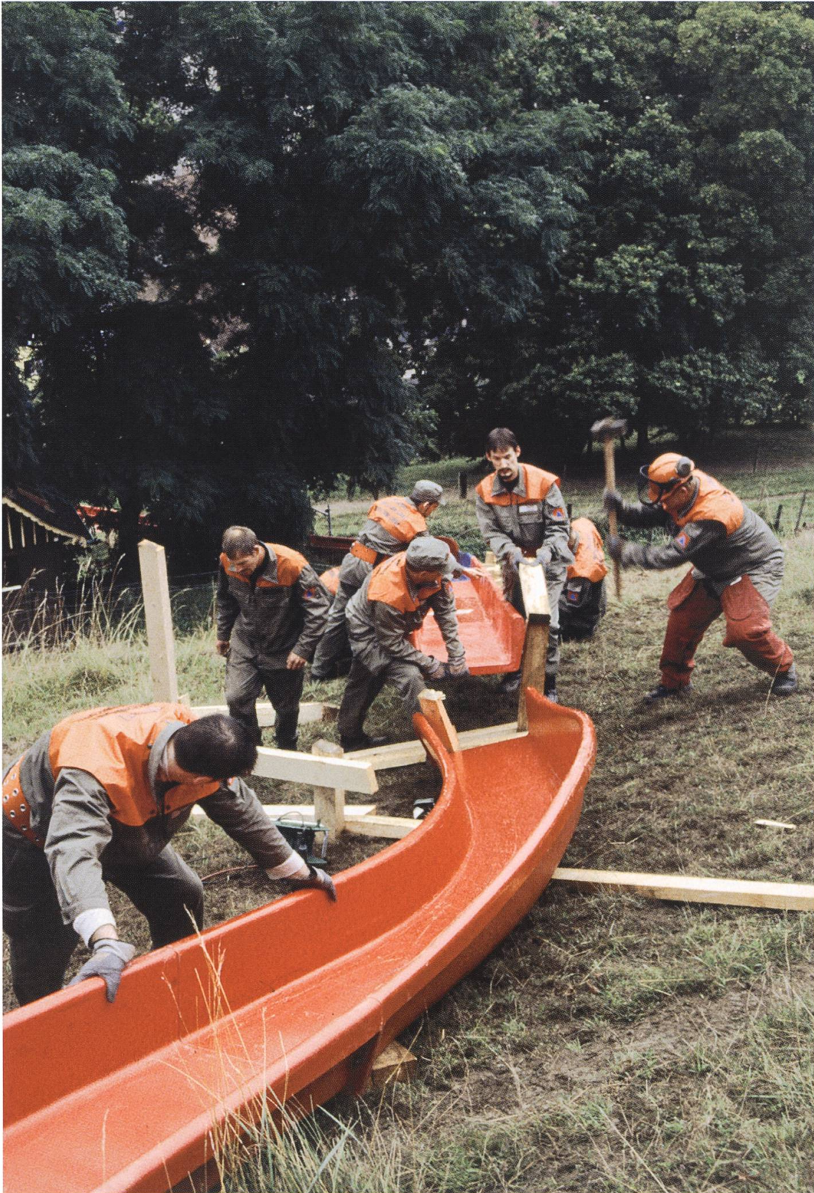
Schwerarbeit am Schlossberg: Konstruktion der Rutschbahn
