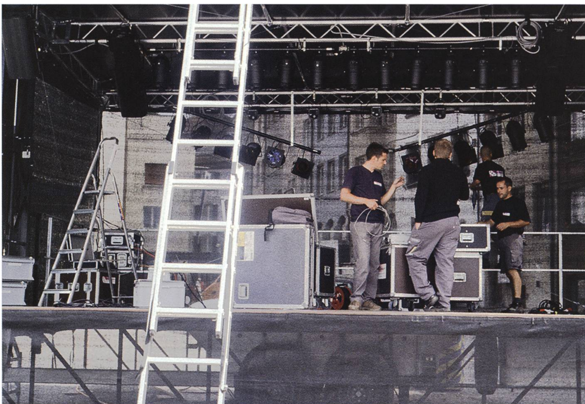
Installation von Licht- und Tonanlagen auf der Bühne in der Eisengasse
