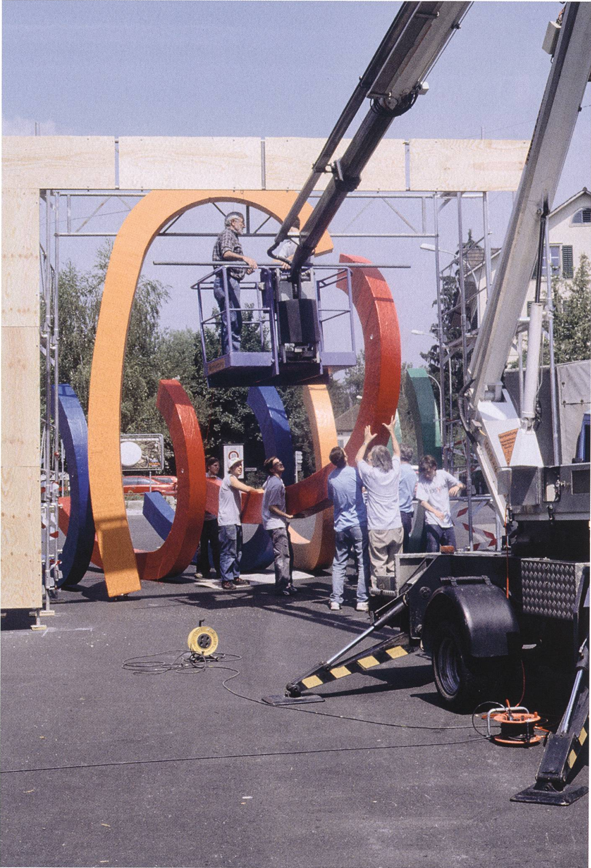
Bau des Stadtores von Holderbank, Möriken-Wildegg und Niederlenz
