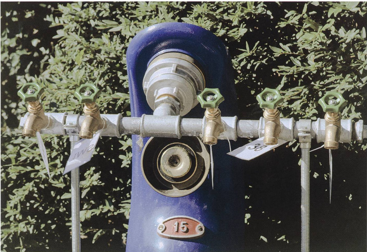
... Gewährleistung der Wasserversorgung durch die SWL
