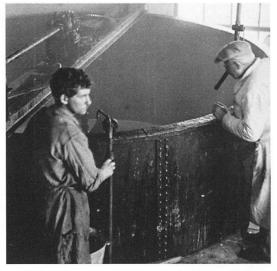
In der Glycerin-Destillieranlage wurde die Unterlauge aus der Kernseifenherstellung aufgearbeitet. Das abdestillierte Glycerin ging vorwiegend in die Sprengstoffindustrie. Das zurückgebliebene Kochsalz wurde wieder zum Aussalzen der Kernseife verwendet.
