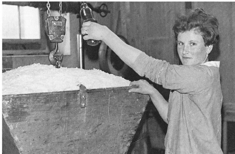
Frau Maria Luongo beim Füllen des Toilettenseifen-Mischers mit 50 kg Grundseifen-Spänen.
