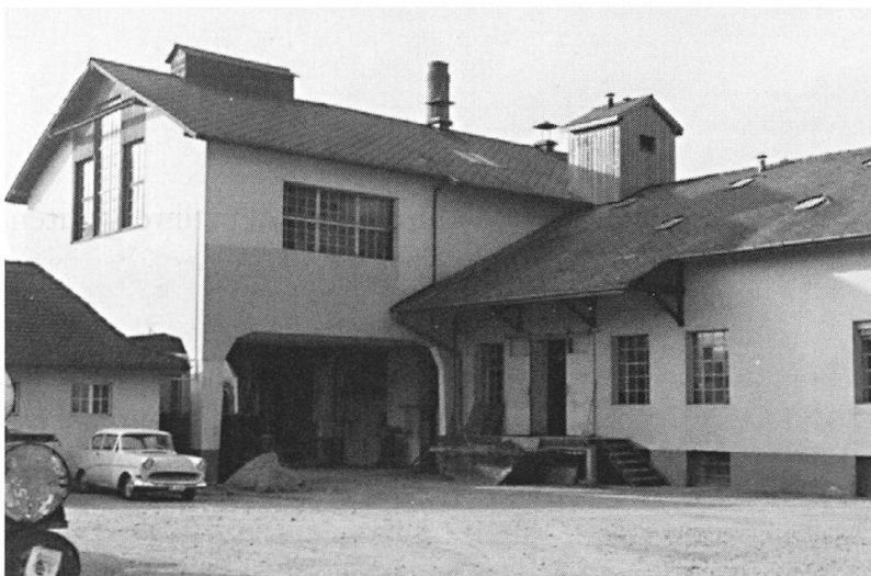
Siedereigebäude im Oktober 1968. Im rechts angebauten Gebäude wurden die in Blöcke gegossenen Seifen, u. a. Glycerinseifen und Bimssteinseifen, geschnitten und gepresst.
