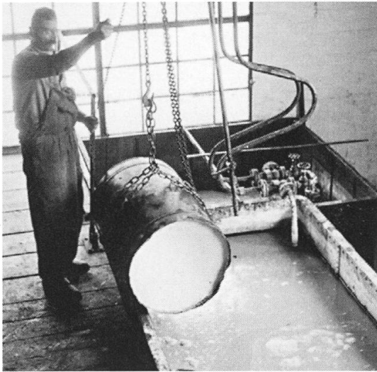
Auspacken der Kühlpresse. Die aus dem Kernseifenkessel abgezogene heiße Seife wird in Platten zu 50 kg gegossen und abgekühlt.
