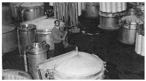
Färberei 1982, Einfüllen der Kunstfasergarnspulen in die Kessel.
