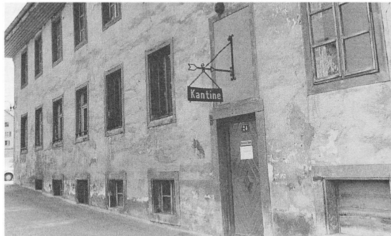
Eingang der Kantine, von dem Gebäude ist nur noch das Schild vorhanden, es befindet sich im Dorfmuseum in Niederlenz.
