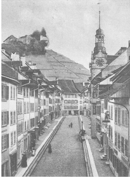
Rathausgasse nach der Tieferlegung, Blick Richtung Restaurant Löwen
