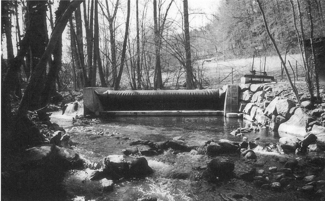
Schlauchwehr der Sigismühle in Seon
