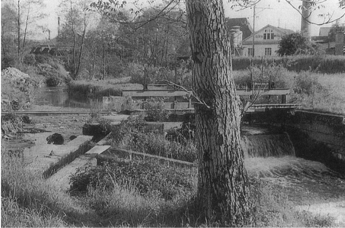
Wehr des Wasserwerks Nr. 522 unterhalb der Wisa-Gloria Werke AG kurz vor dem Abbruch 1942
