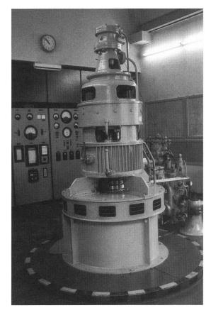
Vertikal-Kaplanturbine mit angebautem Generator
