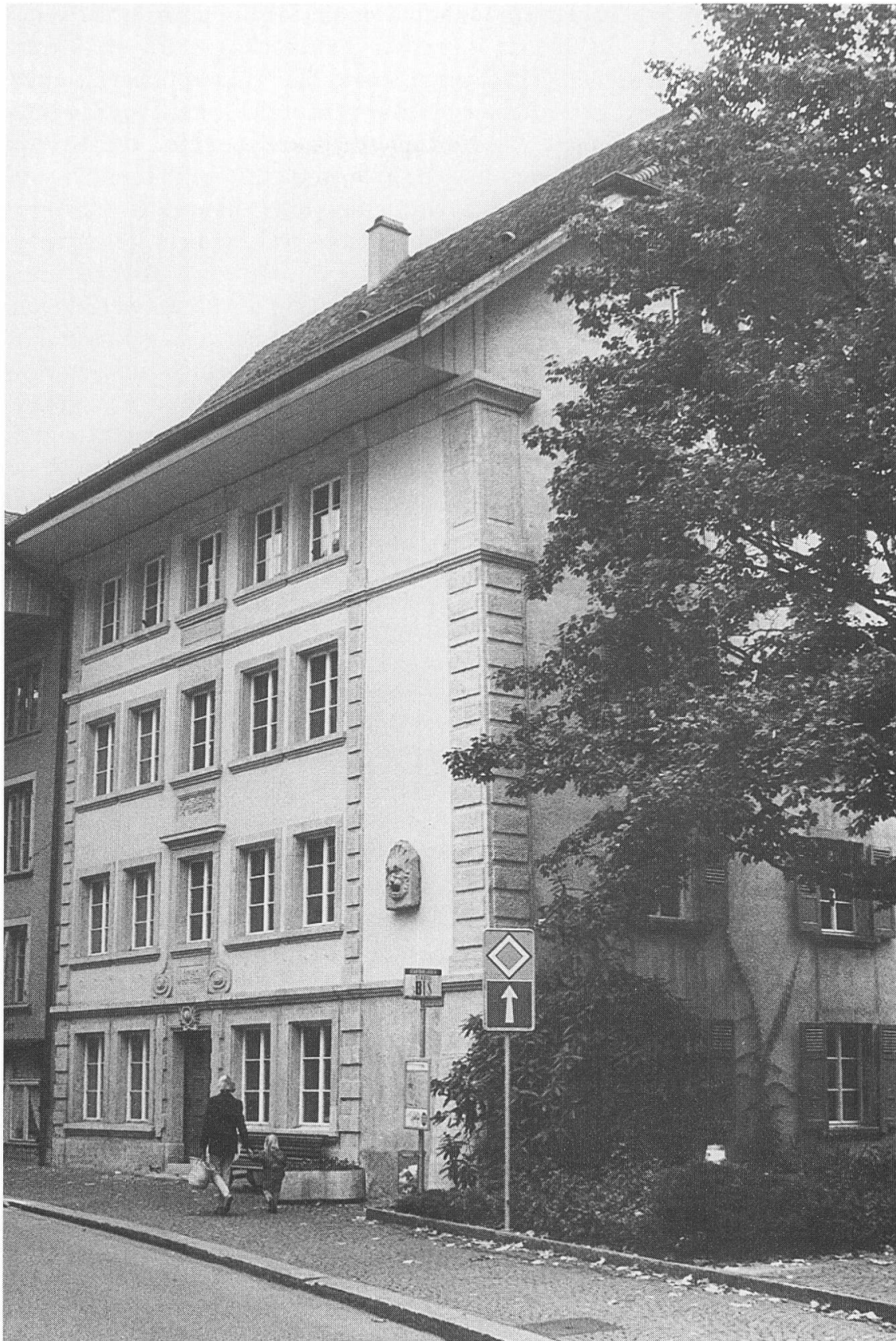
Zusammen mit dem Umbau wurde auch die Fassade des alten Spittels in Richtung Kirchgasse saniert.
