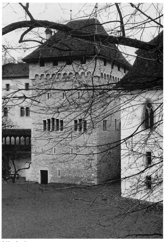
Schloss Lenzburg Palas und rechts anschliessend Turm, unteres Viertel originales Mauerwerk von ca. 1170. Das Gefängnis befindet sich hinter den beiden Lichtschlitzen.
