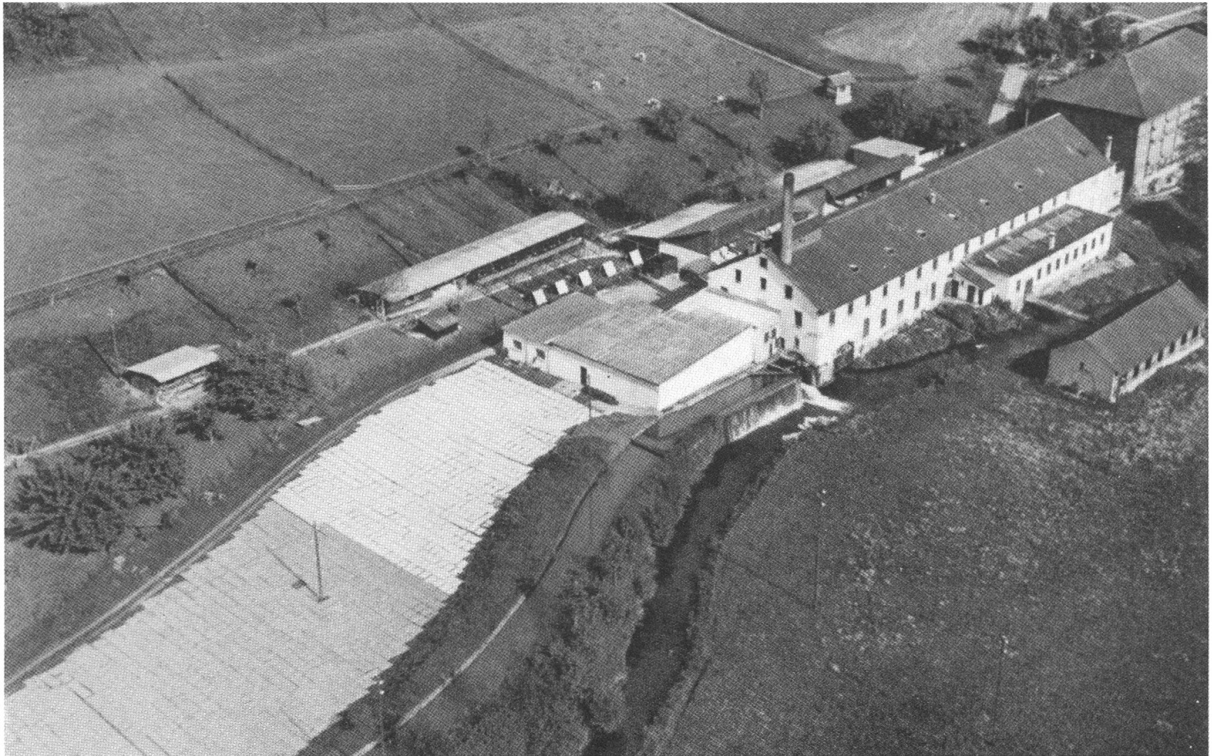
«Plattenplantage»: Die Kartonfabrik Vollmar & Schatzmann trocknete früher den Karton an der Luft.
