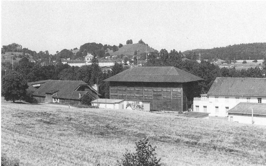
Wird wegen Baufälligkeit abgerissen: Das alte Luftrocknungs-Gebäude der Kartonfabrik.
