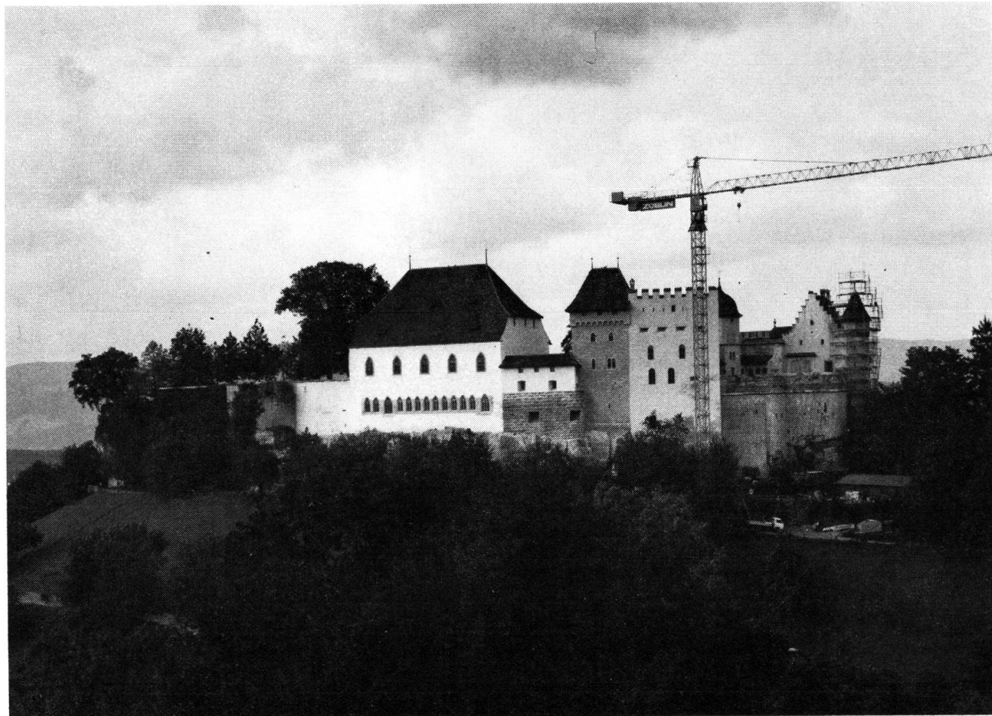
Das Ritterhaus nach der Restaurierung, Südansicht
