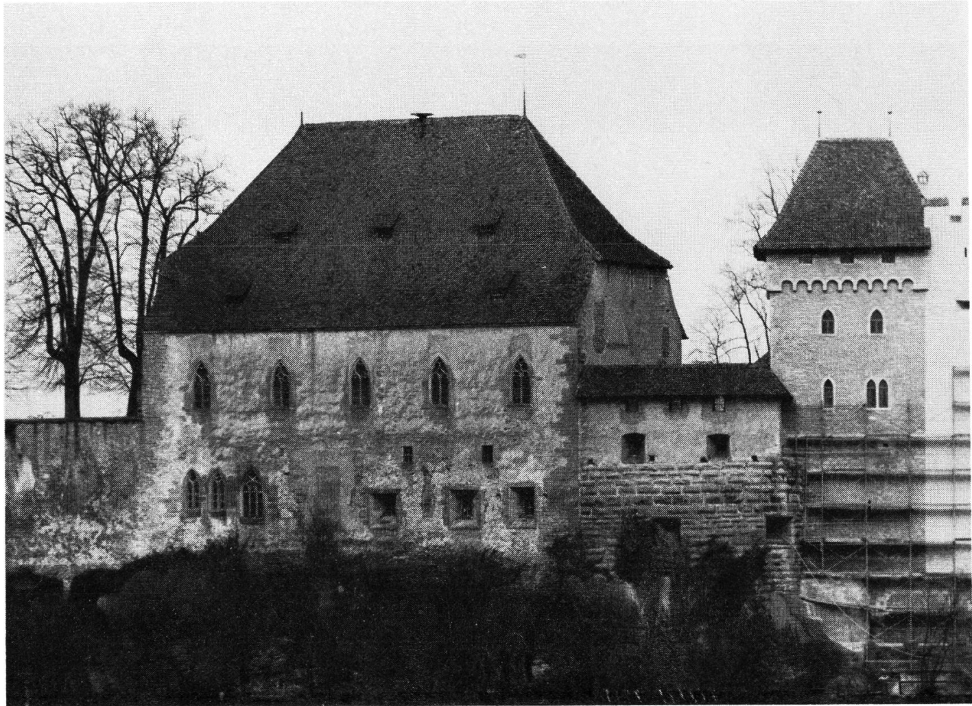
Das Ritterhaus vor der Restaurierung, Südansicht
