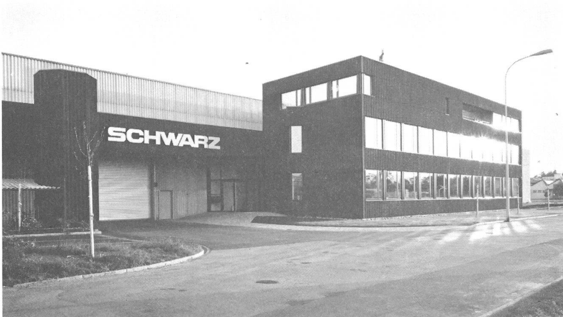
Neues Büro und Halleneinfahrt
