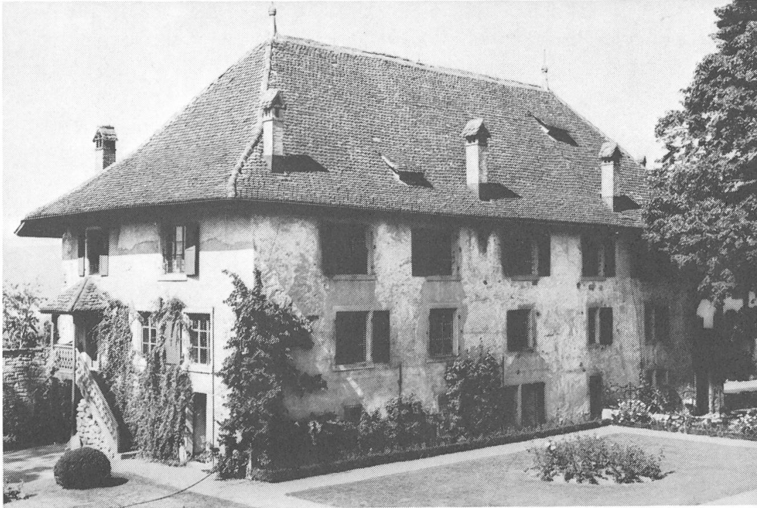
Das alte Bernerhaus vor dem Umbau, wie es noch 1962 aussah. (Foto: Hans Weber)
