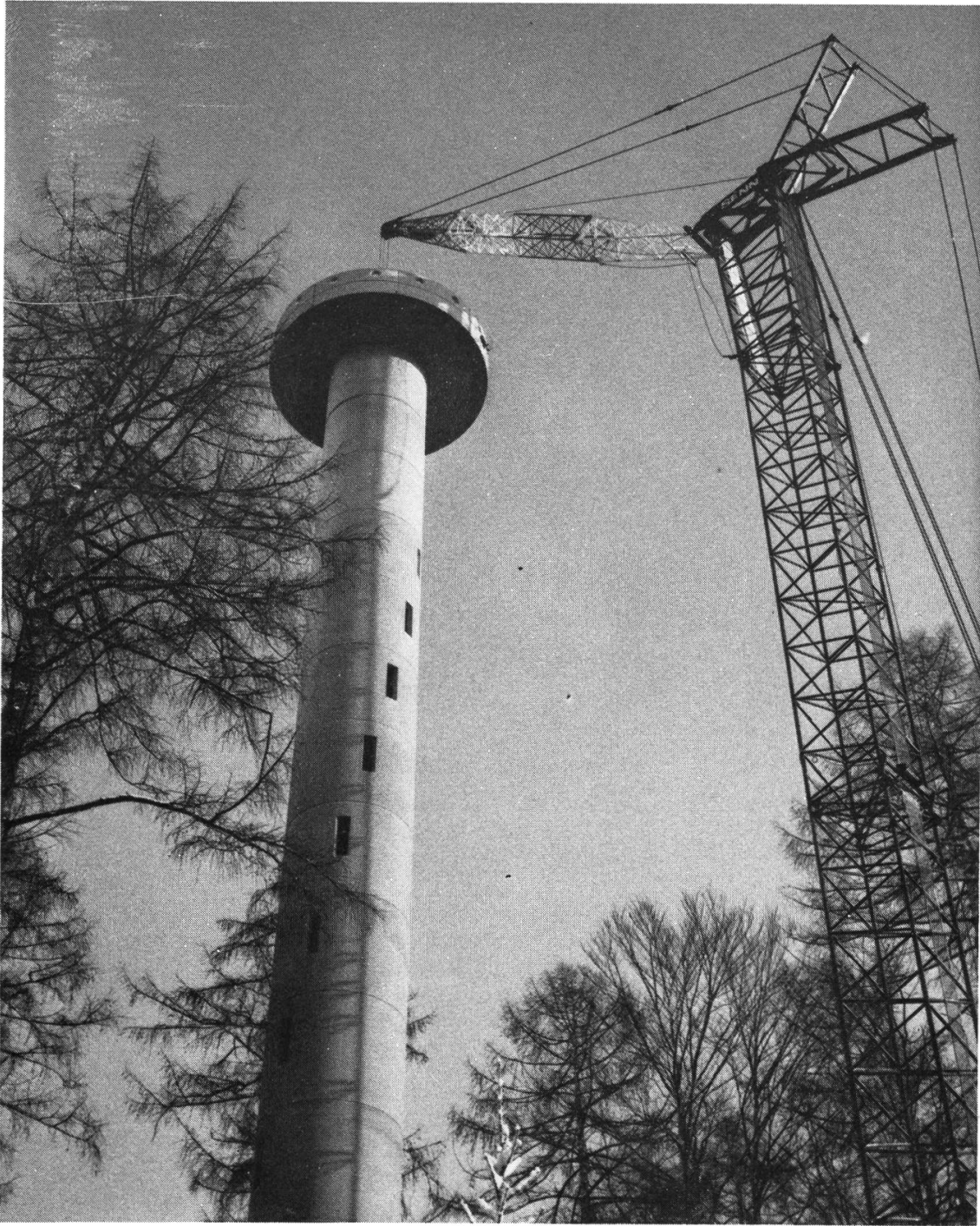
Die Plattform wird aufgesetzt
