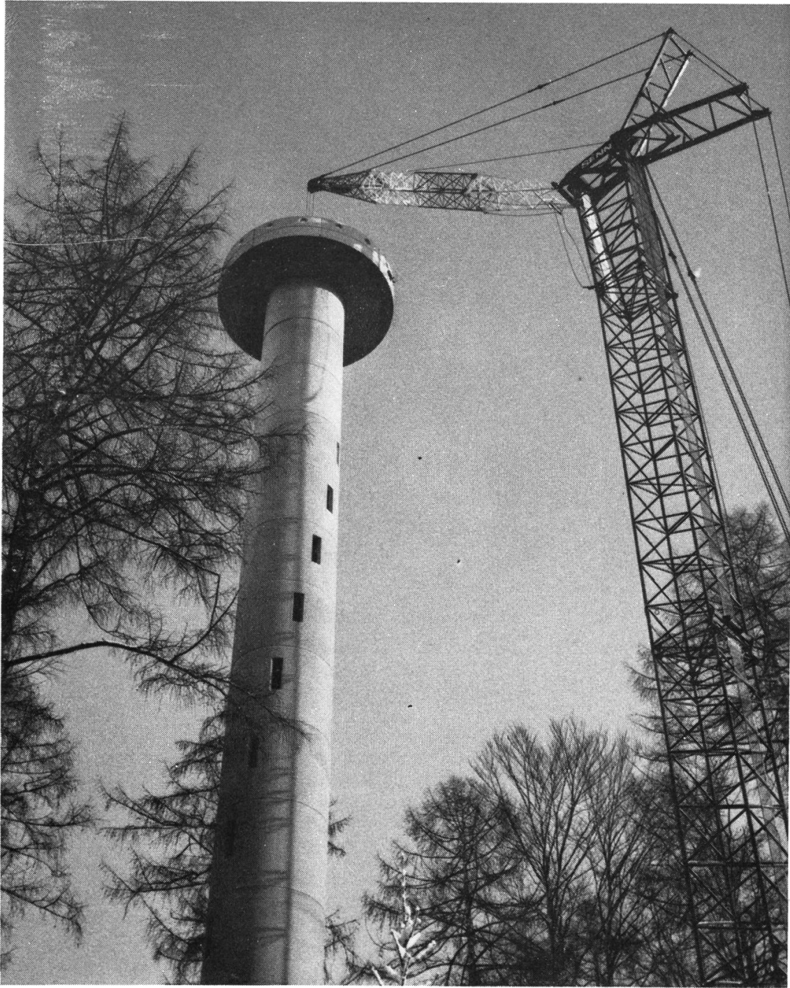
Die Plattform wird aufgesetzt
