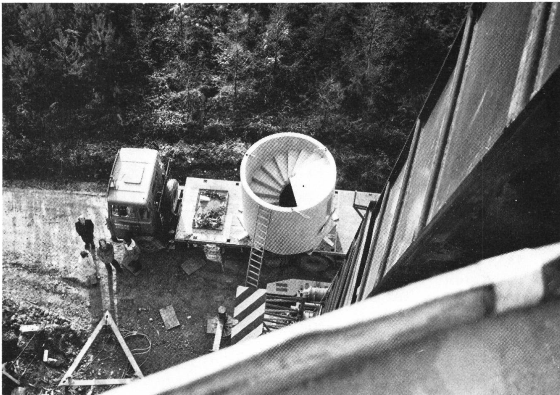
Blick vom Turm auf ein Betonelement
