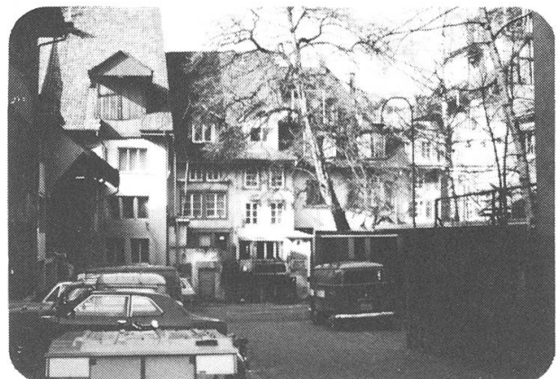
Abb. 183, Störende Ein- und Anbauten an den Rückfassaden der Häuserzeile an der Kirchgasse
