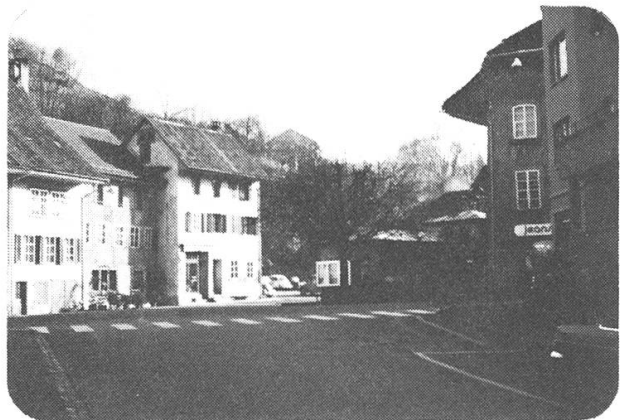
Abb. 174, Beispiel fehlender primärer Raumbildung (Baulücke)
