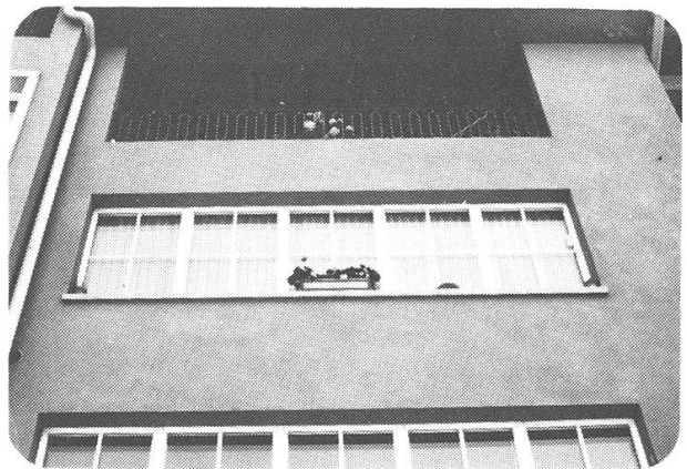
Abb. 136, Regelwidrige Fenstergruppierungen und Laubengestaltung
