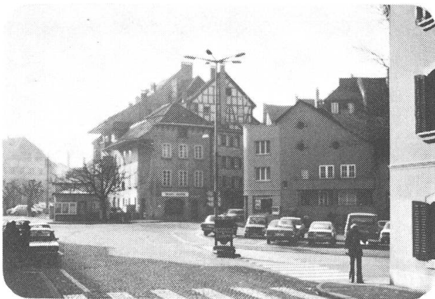
Abb. 113, Erfassung des Kronenplatzes als nicht definierter, unattraktiv gestalteter Raum mit stilfremden Gebäudeelementen an exponierter Stelle (Eckgestaltung, Flachdach)
