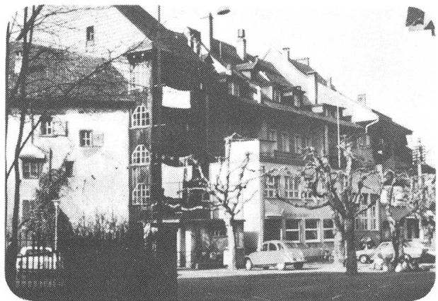
Abb. 22, Vor- und Anbauten an der ursprünglichen Ringmauer im Brättligäu
