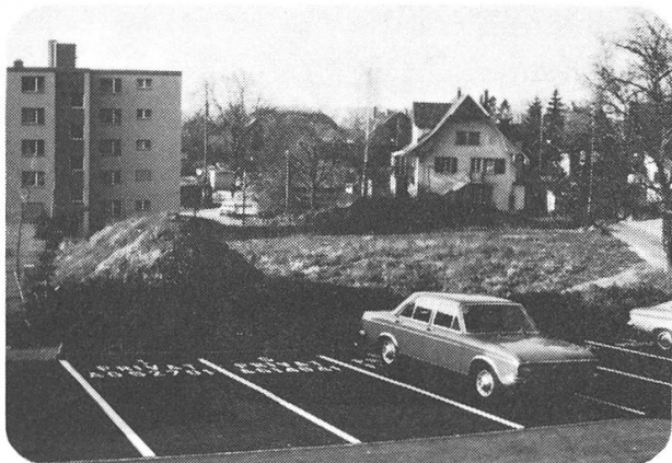
Abb. 33, Ensemble Burghalde von Osten
