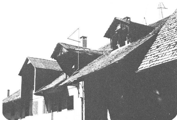
Abb. 99, Ursprüngliche Dachaufbauten (Hendschiker Kirchweg)
