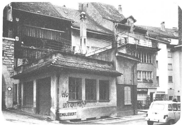
Abb. 149, Abweichende und verwahrloste Stadtbildelemente (Hintere Kirchgasse)
