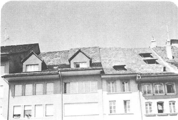
Abb. 97, Ablesbarkeit der Dächer durch Höhenunterschiede
