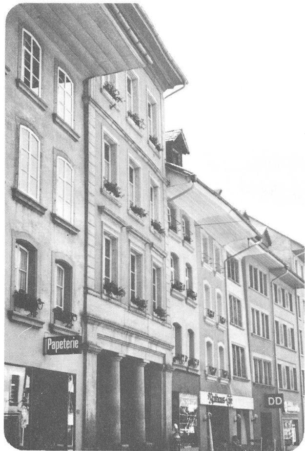
Abb. 130, Als Einzelelemente ablesbare Fenster; Rücksprung im Erdgeschoss als Ausnahme bei öffentlichem Gebäude (Altes Amtshaus)
