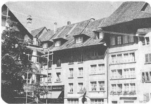
Abb. 100, Neuere Dachaufbauten (Leuengasse)
