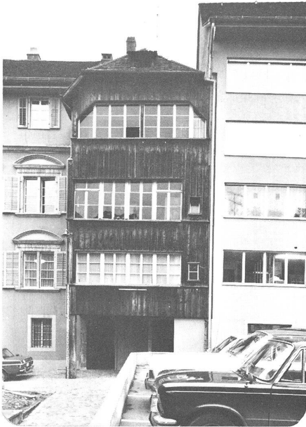
Abb. 157, Durchgang Metzgplatz - Rathausgasse, unter Haus mit Holzlauben
