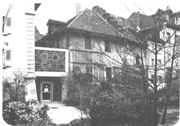
Abb. 35, äusserst störende Verbindung Spittel - ursprüngliche Ringmauer
