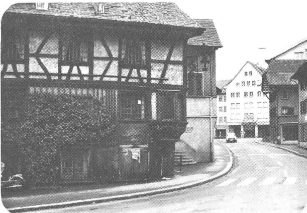
Abb. 109, Strassenknick nach Norden; Erfassung des Heimatmuseums links und des dahinter liegenden störenden Nachbargebäudes; Blick auf das zu grossmassstäbliche Gebäude am Schulhausplatz (siehe Kap. 5.1)
