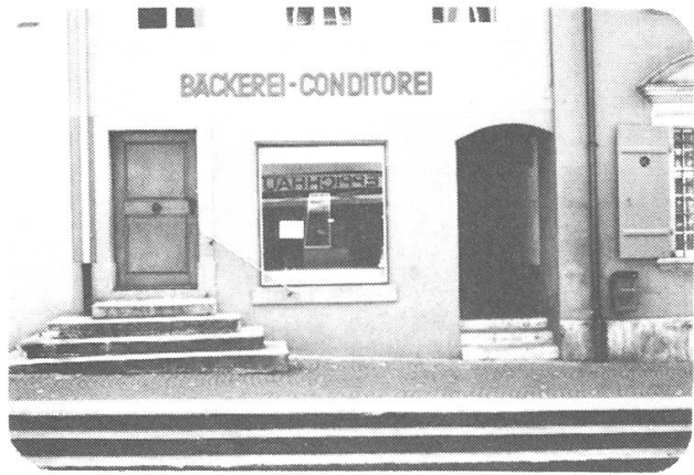
Abb. 148, Unattraktiver Fussgängerdurchgang (Rathausgasse/Rathausgässli)
