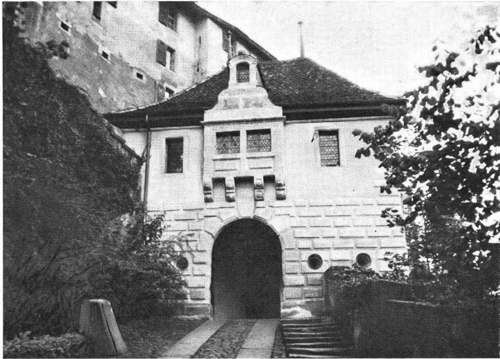
Das renovierte mittlere Torhaus
