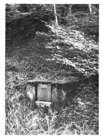
Sammelschacht Nr. 8 (siehe auch Situationsplan Nr. 2) Diesem Schacht wird Wasser aus zwei Quellfassungen zugeleitet
