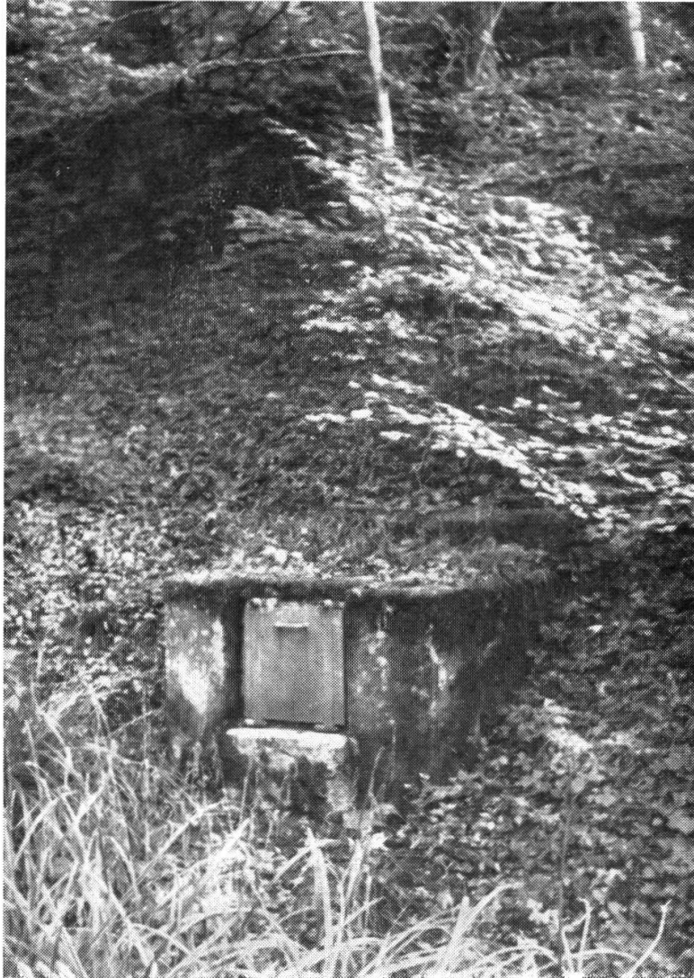
Sammelschacht Nr. 8 (siehe auch Situationsplan Nr. 2) Diesem Schacht wird Wasser aus zwei Quelfassungen zugeleitet
