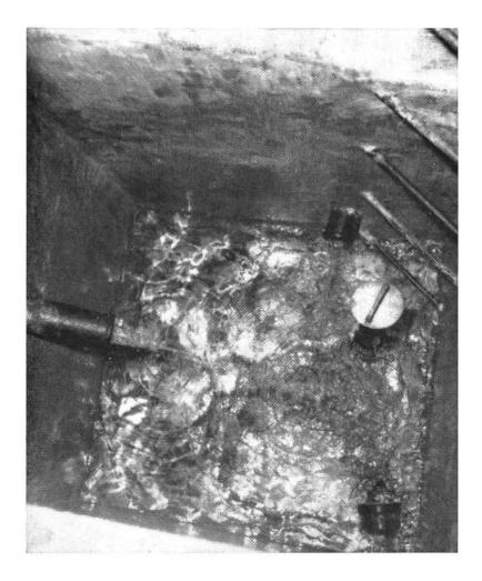
Blick in einen der zwölf Sammelschächte Man erkennt die Einläufe von zwei Quellen und unten rechts die Ablauföffnung nach der Sammelleitung
