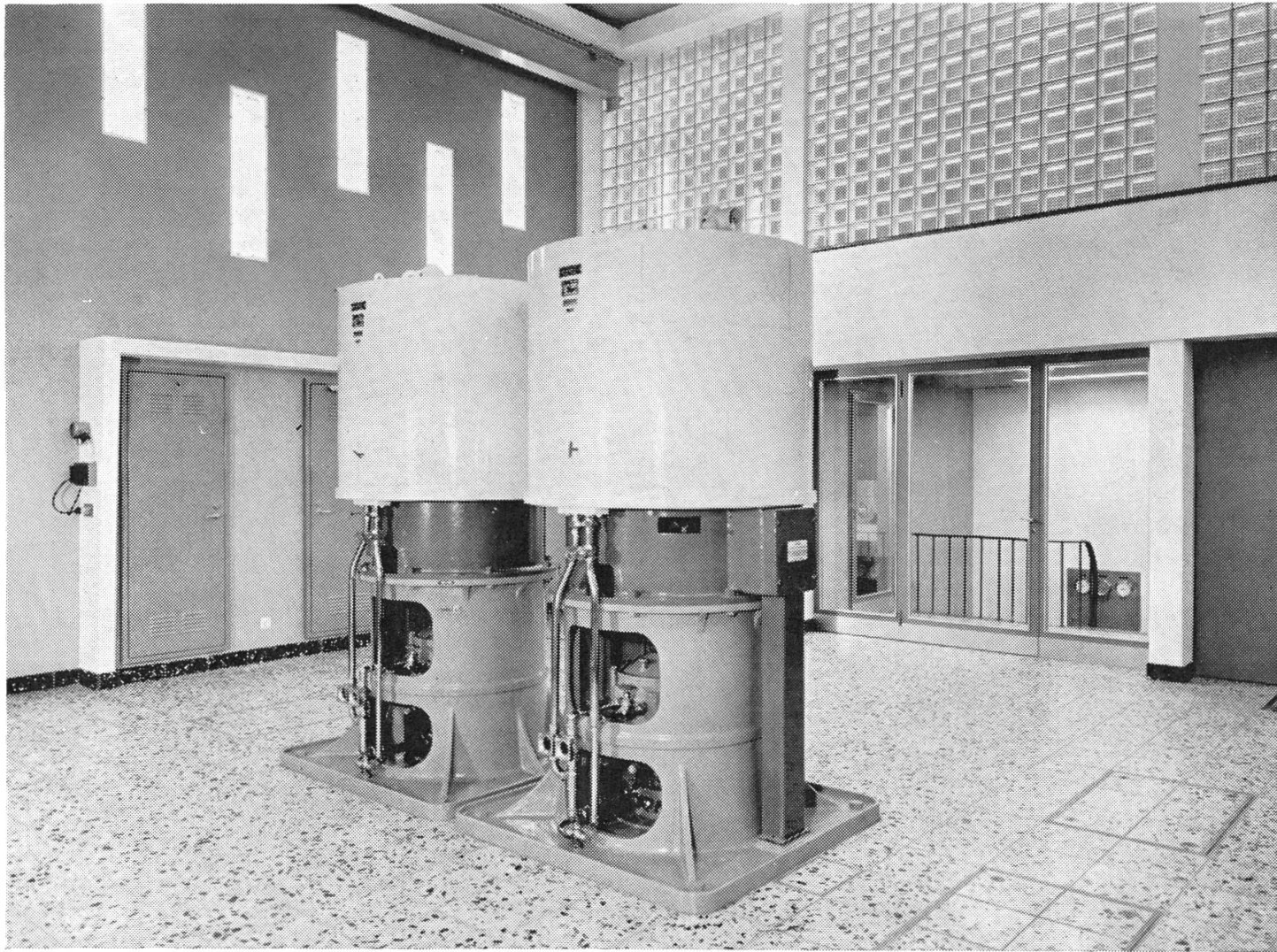
Motorenraum des Pumpwerkes, ausgerüstet mit zwei luftwassergekühlten Elektromotoren Brown, Boveri von 425 PS Leistung
