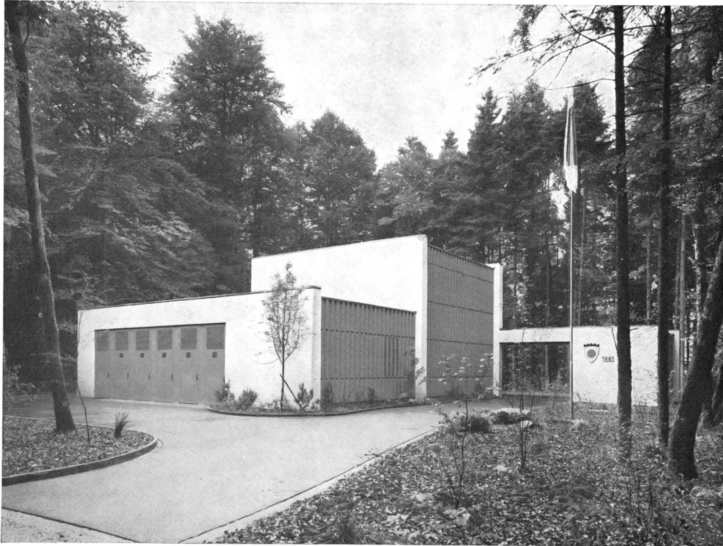
Das Gebäude des Grundwasserpumpwerkes Hard II, ein durch seine einfache, klare Form sich auszeichnender Zweckbau
