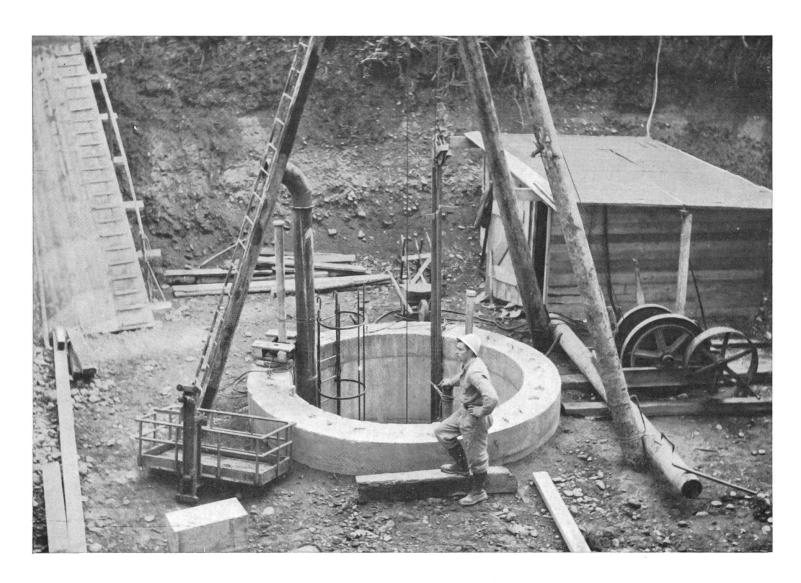
Baugrube für das Pumpwerkgebäude mit fertiggestelltem Fassungsschacht
