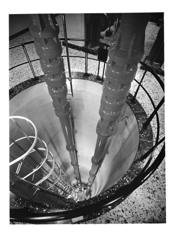
Blick in den 35 Meter tiefen Brunnenschacht von 3 Metern Durchmesser Die beiden 30 Meter langen Sulzer-Bohrlochpumpen vermögen zusammen 15 000 Minutenliter nach dem Reservoir Goffersberg zu fördern
