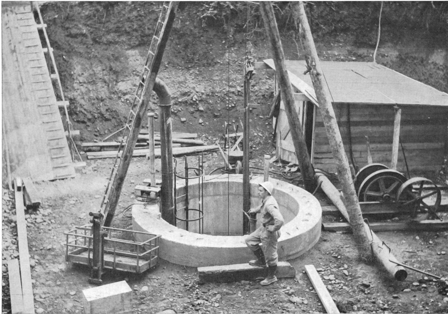
Baugrube für das Pumpwerkgebäude mit fertiggestelltem Fassungsschacht
