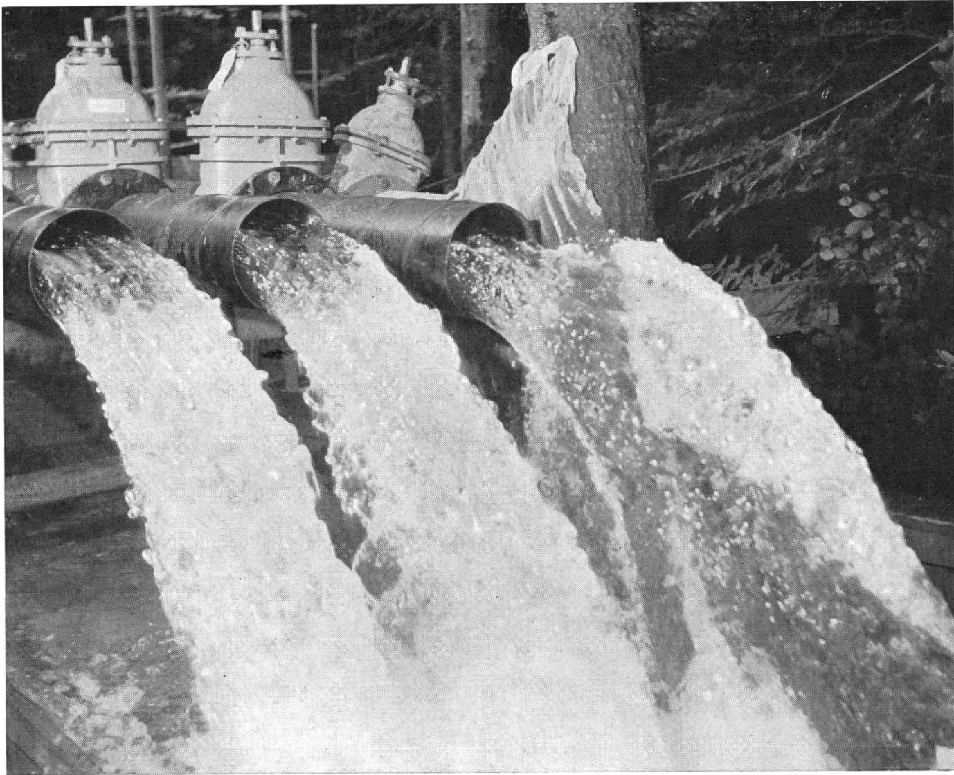
Pumpversuch mit 30 000 Minutenlitern Wasserentnahme, 15. Oktober 1958
