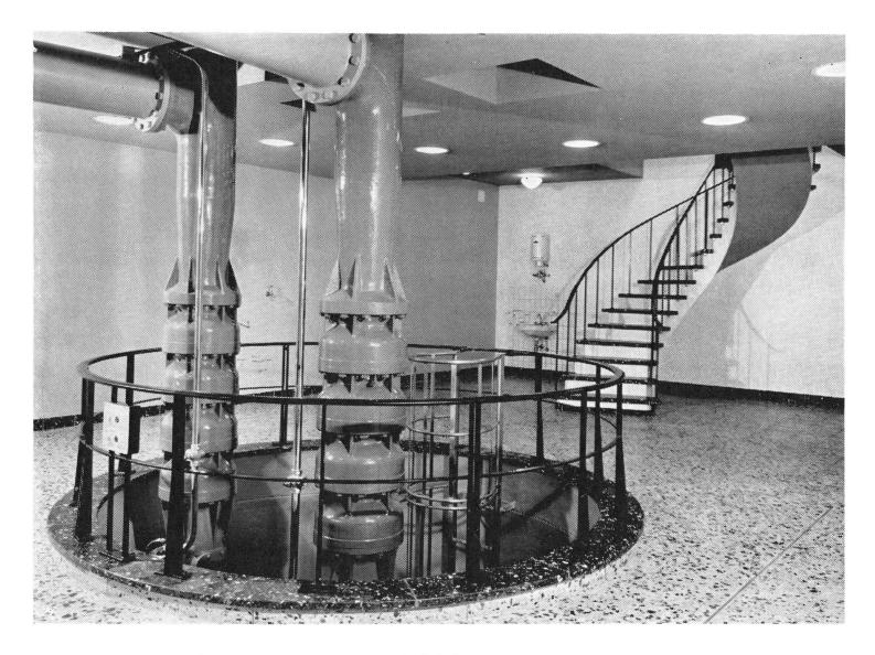
Rohrkeller des Pumpwerkes mit Schacht und zwei der vier vorgesehenen Bohrlochpumpen unmittelbar unter den Motoren
