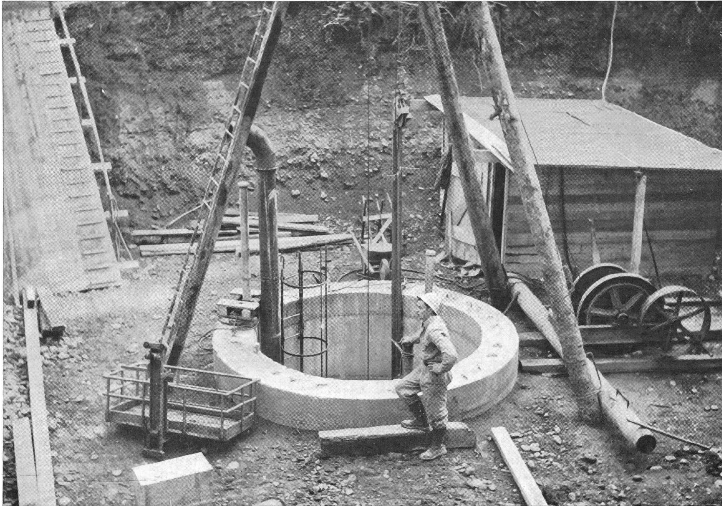
Baugrube für das Pumpwerkgebäude mit fertiggestelltem Fassungschacht
