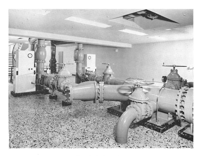
Rohrkeller des Pumpwerkes Klappen, Schieber und hydraulische Steuerapparate
