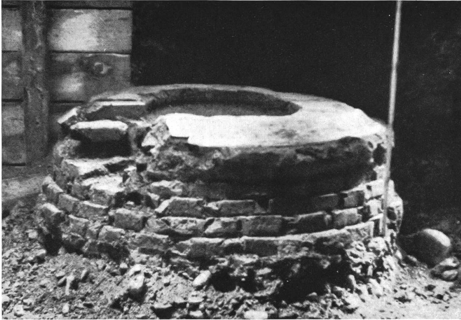
Abb. 1 Stand oder Stock, über dem der Kern aufgemauert wurde
