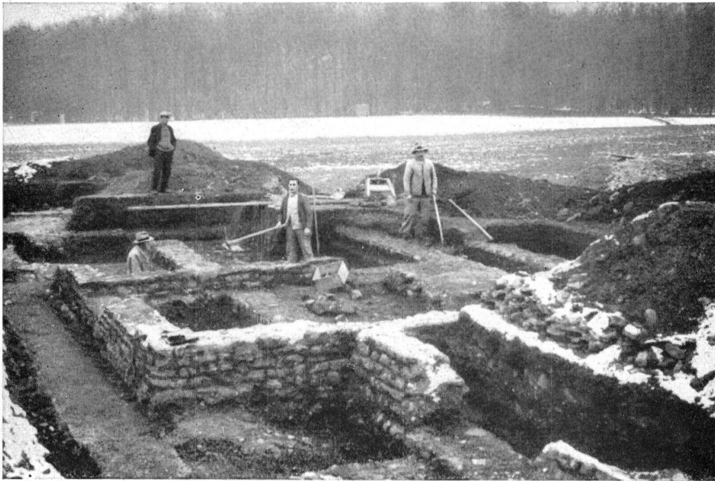
Abb. 2 Haus 1, Räume 5–9. Aufgenommen von Süden. (Grabung 1933)
