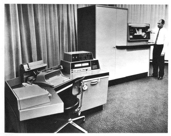
Intertype Fototronic: Steuerpult (links), elektronische Zähleinheit zur Ermittlung der Wortzwischenräume und Vornahme der Trennungen (Mitte) und Belichtungseinheit (rechts).
