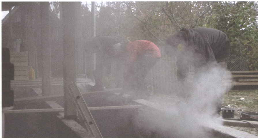
Bauen am Pschüttloch.
