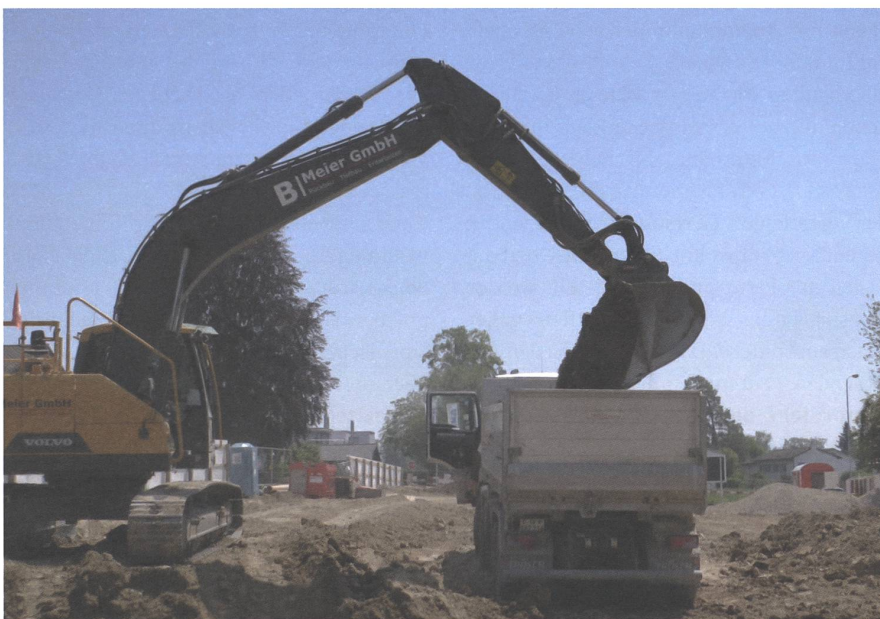
Fünf Meter tief wird die Ackerfläche für den geschützten Platz für Autos ausgeschöpft.
