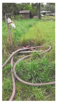
Ein Starkstromanschluss in Zisternennähe erleichtert die Wasserentnahme beträchtlich, weil so die Tiefbrunnenpumpe im Sommer in der Zisterne bleiben kann und nur ein Schalter bedient werden muss.
