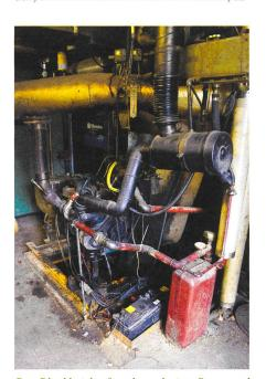
Das Blockheizkraftwerk produziert Strom und Wärme aus altem Frittieröl. Foto: Markus Schär
