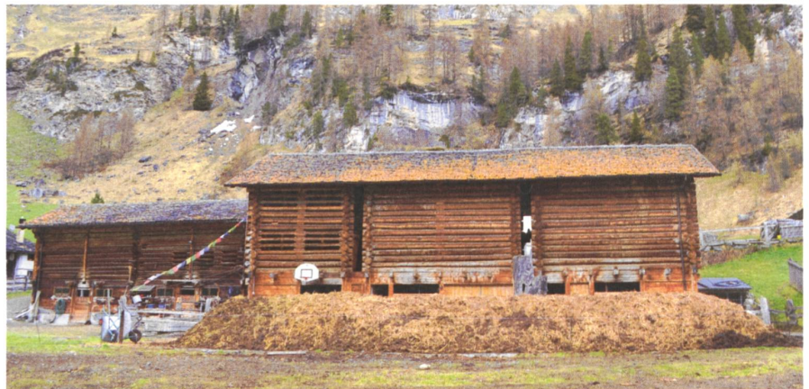
Der «Bioreaktor Heustock» von aussen mit den zwei Querluftschlitzen.
