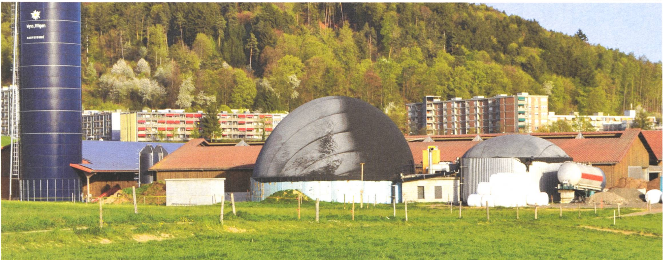
Biogasanlage auf Bauernhof in Ittigen/BE.
