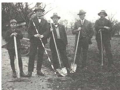
patenstich vor mehr als 75 Jahren.
